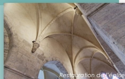
Restauration de l'église
