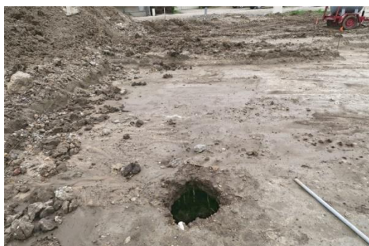
« Frontis » sur un chantier
