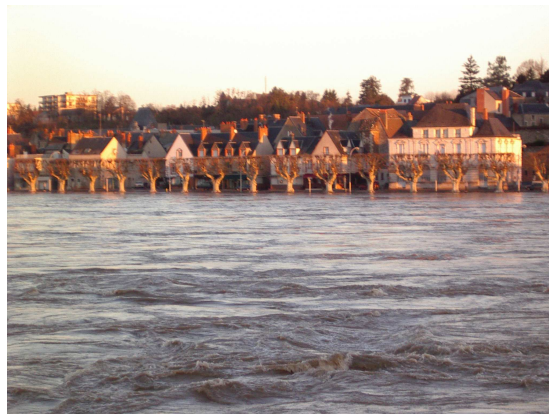
Inondation du quai de Gien
