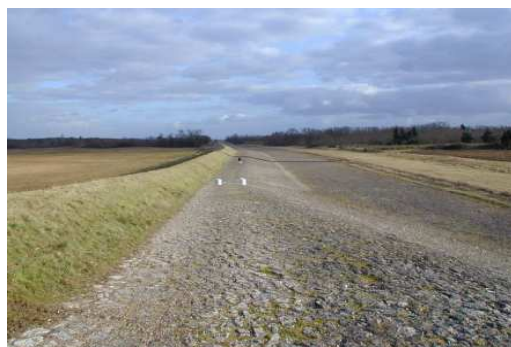
Déversoir de Jargeau
