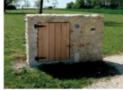
Intégration des coffrets techniques dans un ensemble maçonné
