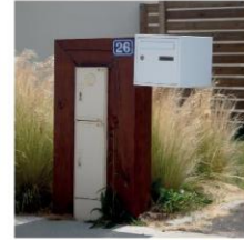
Intégration des coffrets techniques dans un ensemble maçonné
