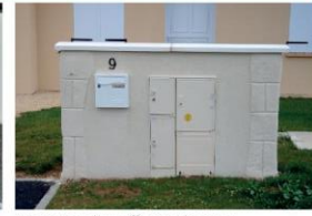
Intégration des coffrets techniques dans un ensemble maçonné
